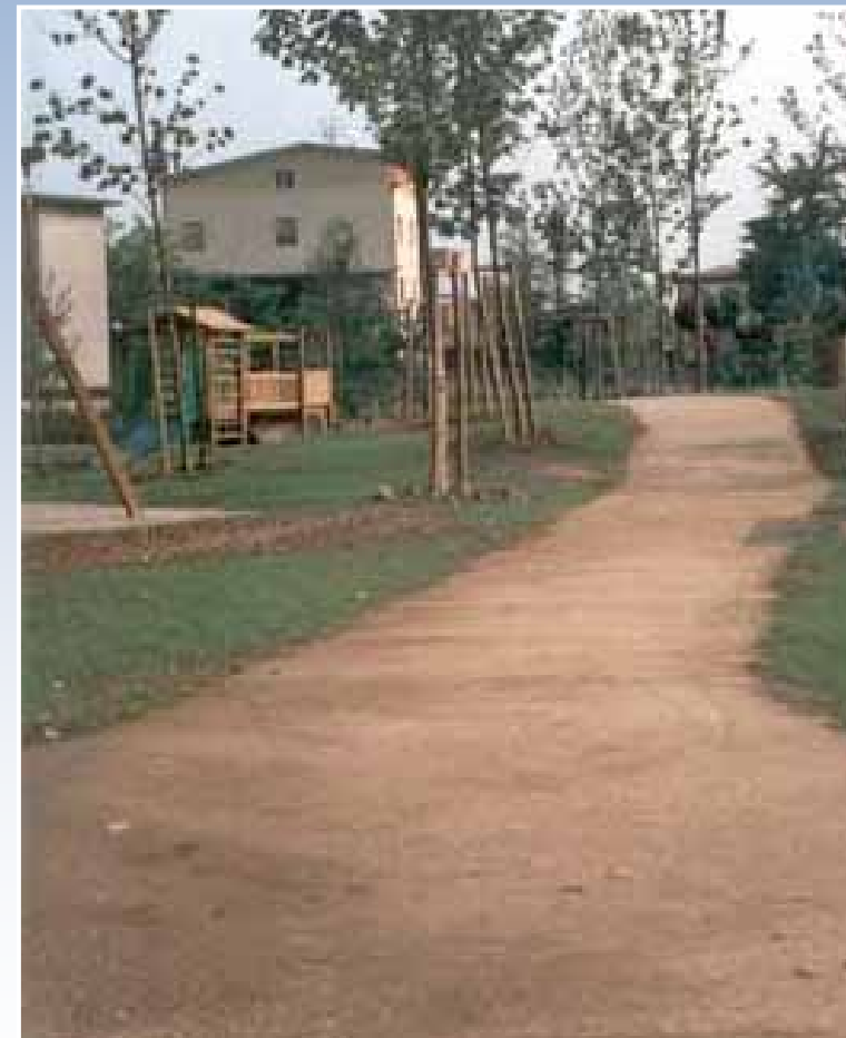
Esempio di pavimentazione stabilizzata in glorit
